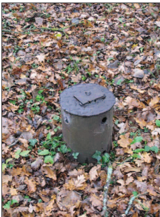
Figure 9 : Piézomètre présent au sein du périmètre de protection immédiat
